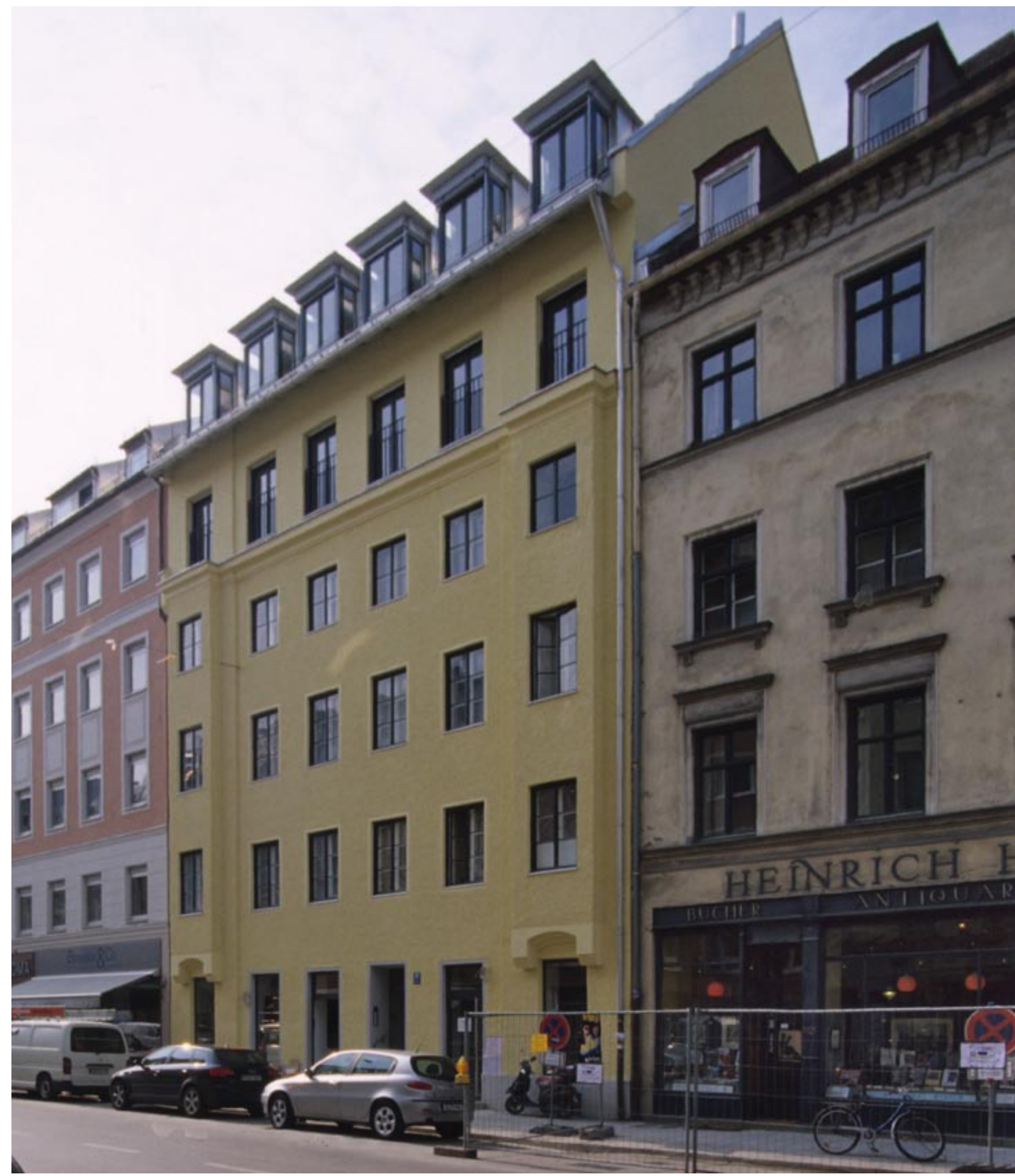
Straßenansicht nach erfolgter Aufstockung
