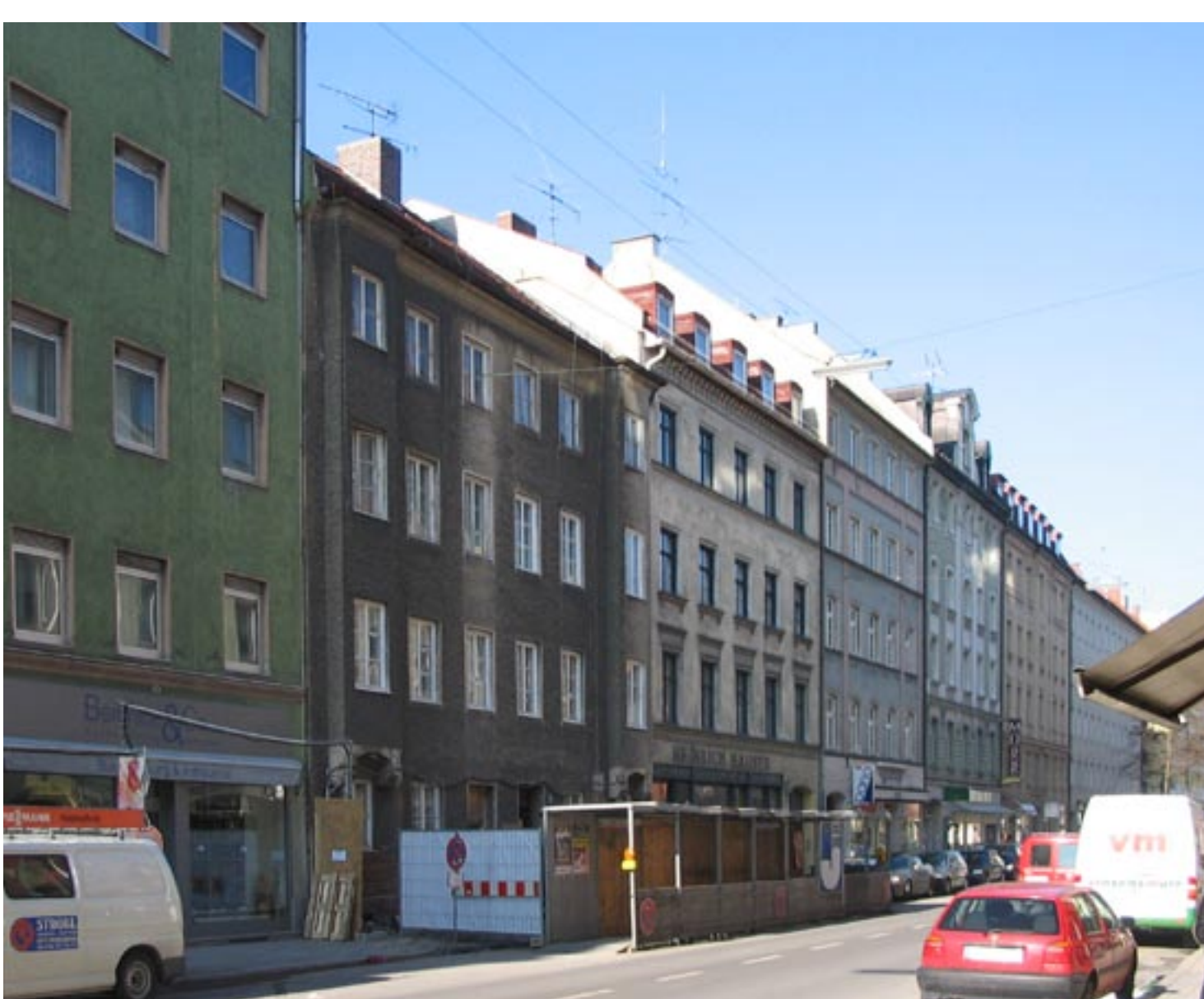
Bestand vor Aufstockung (Blick nach Westen)
