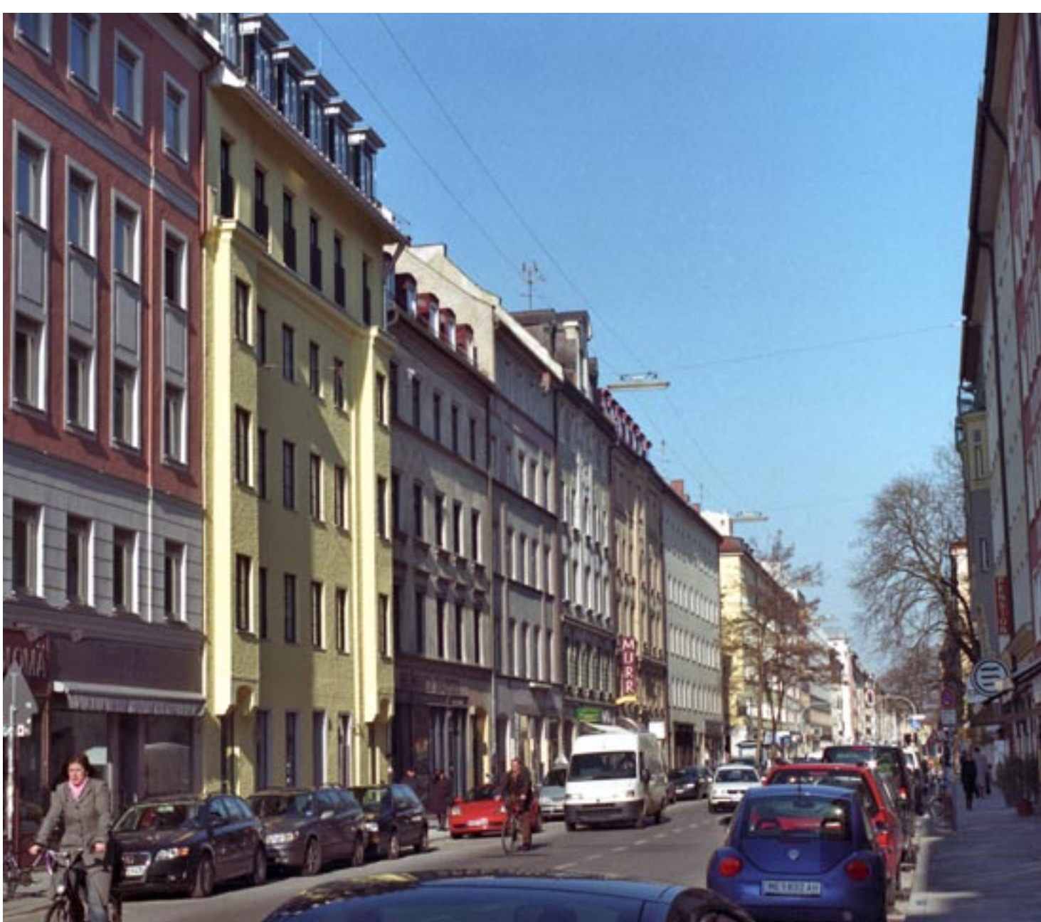
Straßenansicht nach erfolgter Aufstockung
